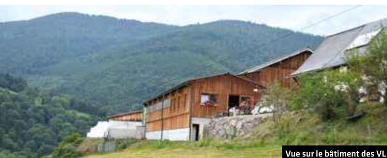
Vue sur le bâtiment des VL.
