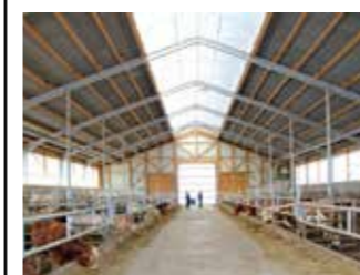
Lubratec® Faîtage éclairant ventilé
